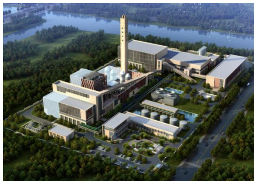
浙能印染污泥焚烧发电项目
