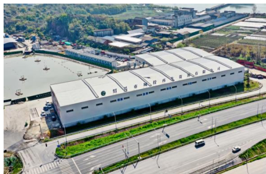
城投再生资源废弃建筑泥浆资源化项目
