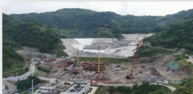
新昌垃圾焚烧厂
